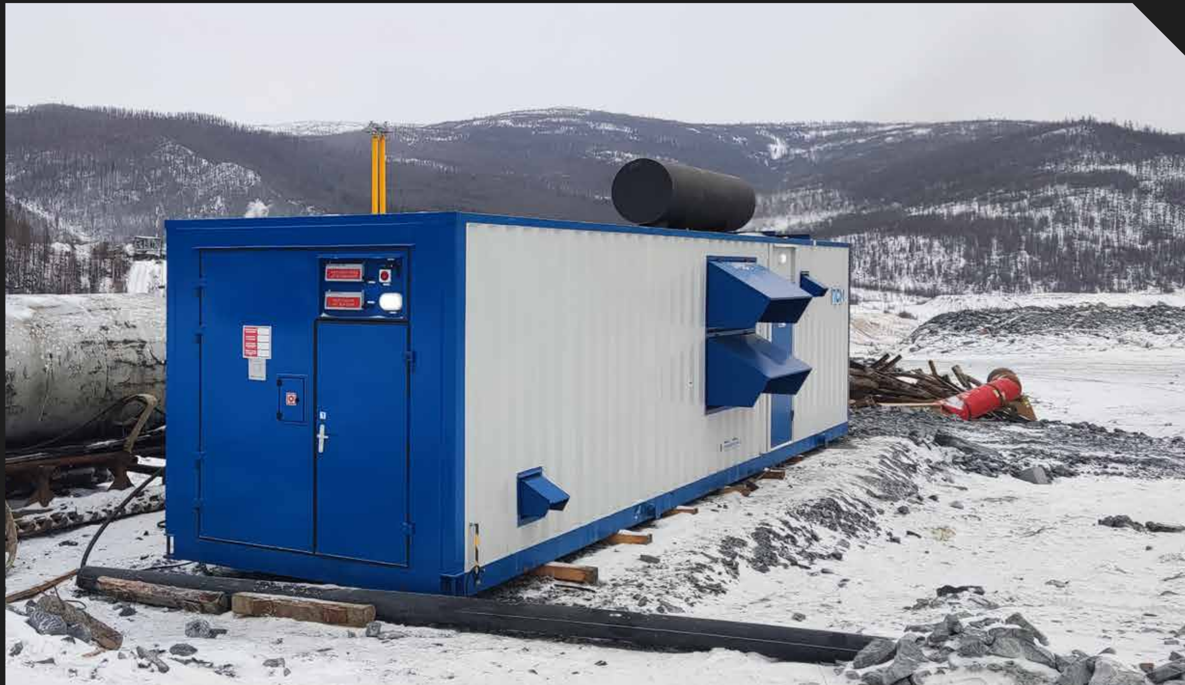
Дизельная электростанция 1,2 МВт
