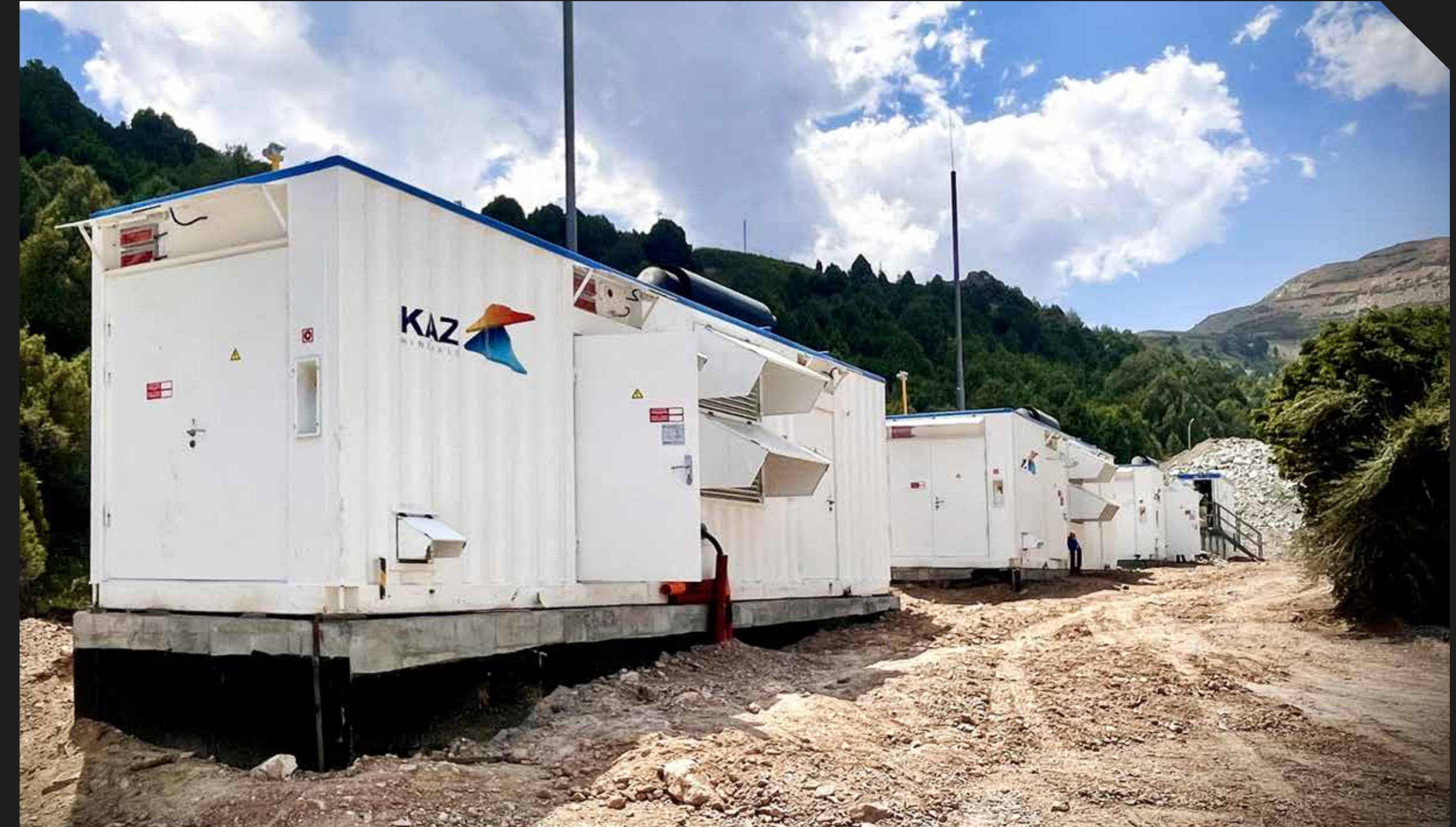
Энергокомплекс 4,5 МВт для подземного рудника
