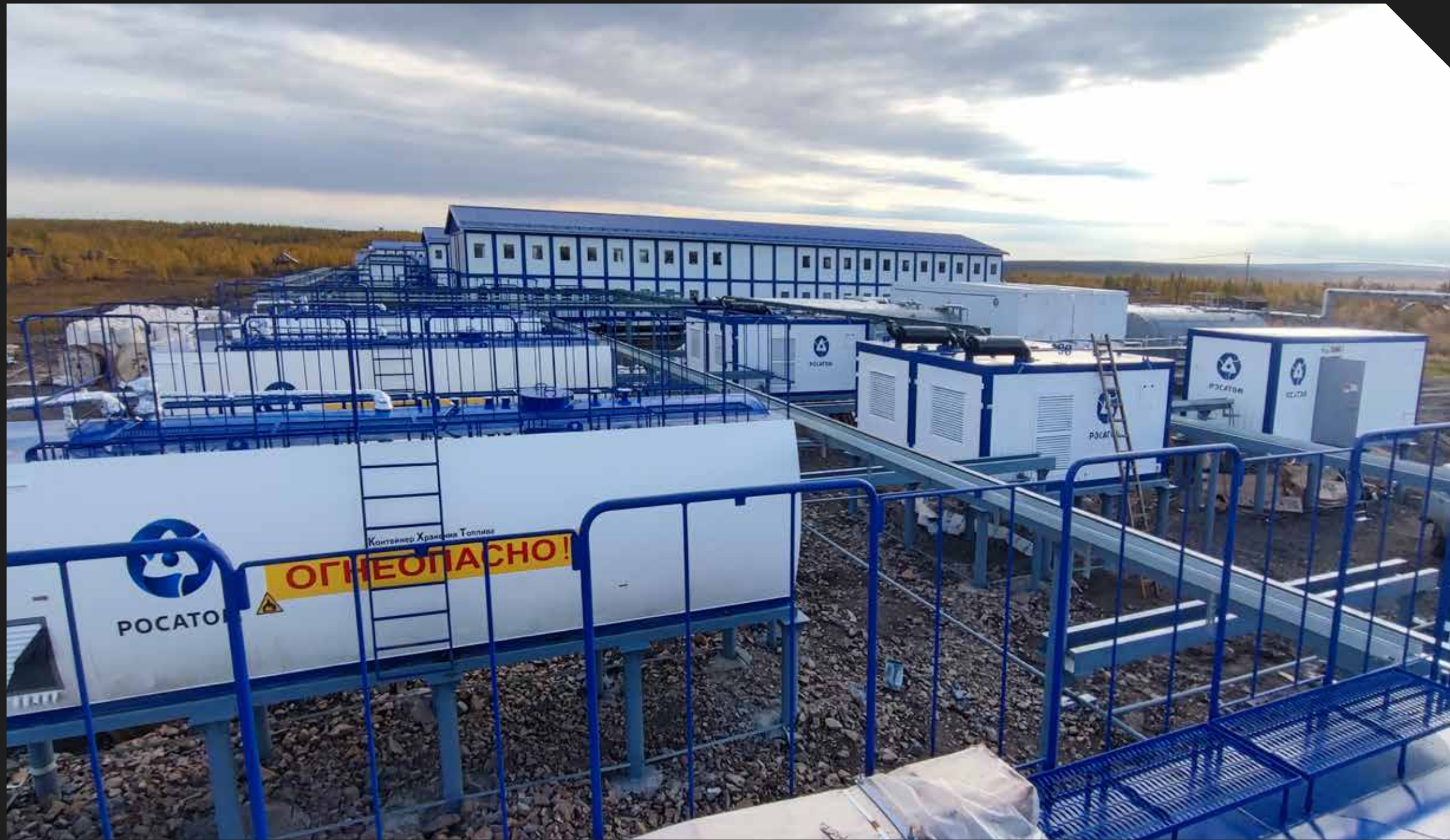
Дизельный энергокомплекс 2,4 МВт для первой АСММ в Арктике
