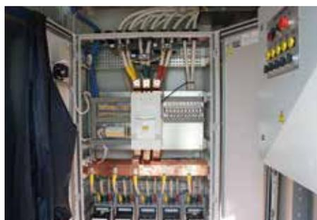
Нагрузочные модули ПСМ поставлены в собранном виде, полностью готовые к установке на объекте, без необходимости сложного дополнительного монтажа. Это обеспечило удобство и безопасность транспортировки готового оборудования и быстрый старт его эксплуатации на объекте.
