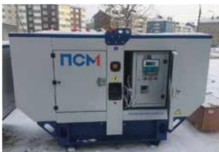
В поставку вошли два нагрузочных модуля. Это оборудование тестирует ДГУ, которые долгое время находятся в резерве, а также помогает догружать станции, чтобы они работали в оптимальном режиме.
