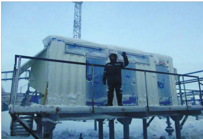
**Рис. 1.** Дизельный энергокомплекс ПСМ суммарной мощностью 12 МВт для газоконденсатного месторождения компании «НОВАТЭК»
