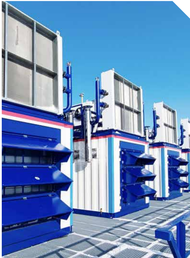
NOVATEK 8 MW 燃气发电厂
