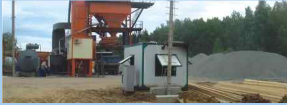
ADV-460 поставлена строительной компании Hochtief, на строительстве завода Ferrero Roche в пос. Ворша Владимирской области
