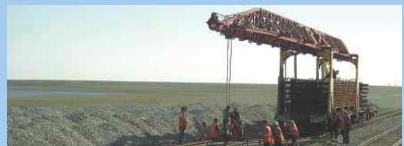
ADV-500 (2 шт) в качестве источника основного энергоснабжения на строительстве железной дороги на Ямал
