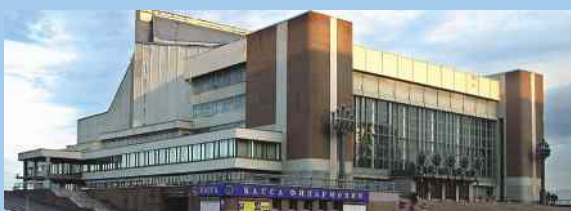
ADV-250 в качестве резервного источника электроэнергии в Красноярской областной филармонии
