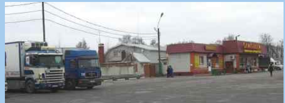
ADV-200 для обеспечения резервного энергоснабжения торгово-ресторанного комплекса на трассе М7
