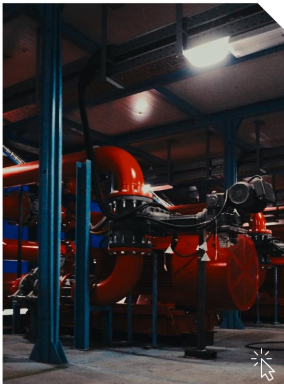
БНС пожаротушения и производственного водоснабжения для компании «Русская платина»
