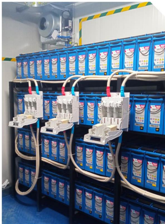
Источники бесперебойного питания (ИБП)
