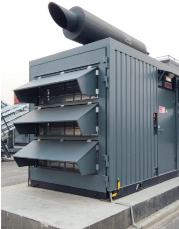
Дизельные электростанции (ДЭС)
