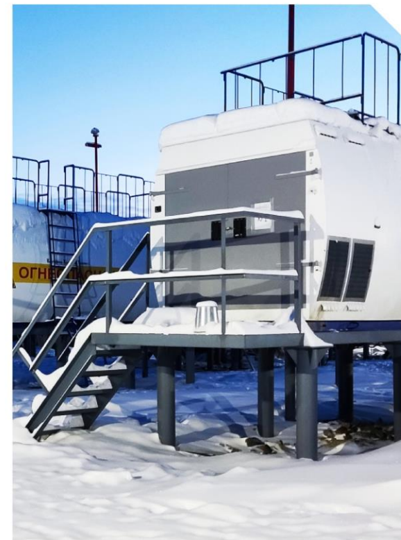
Контейнеры для хранения топлива
