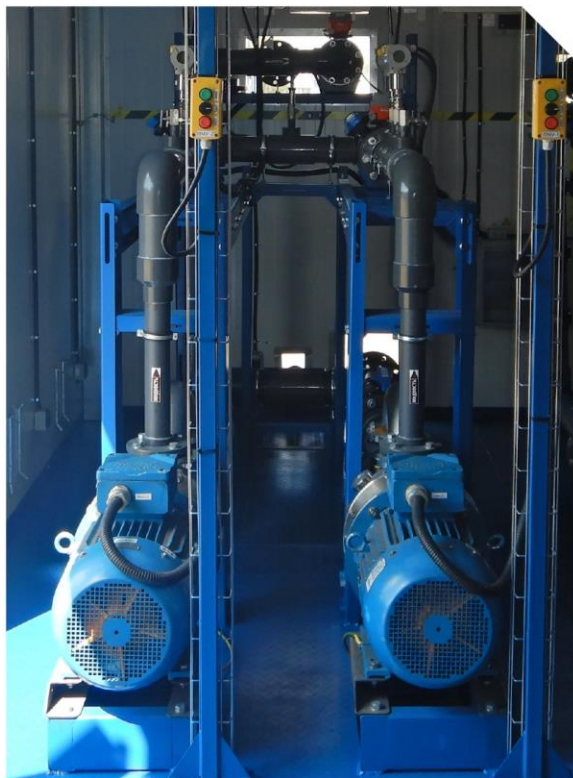
БНС для подачи стоков атомной промышленности
