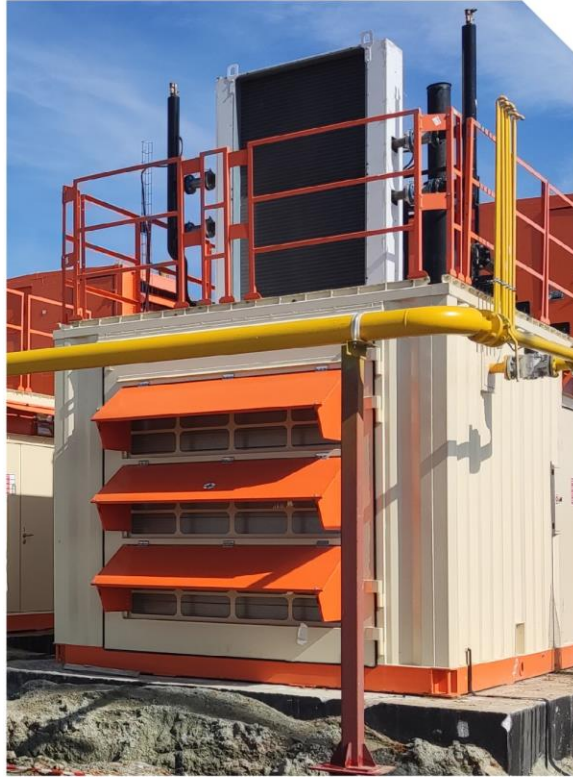
Энергокомплекс 3 МВт для СПГ-завода на Урале
