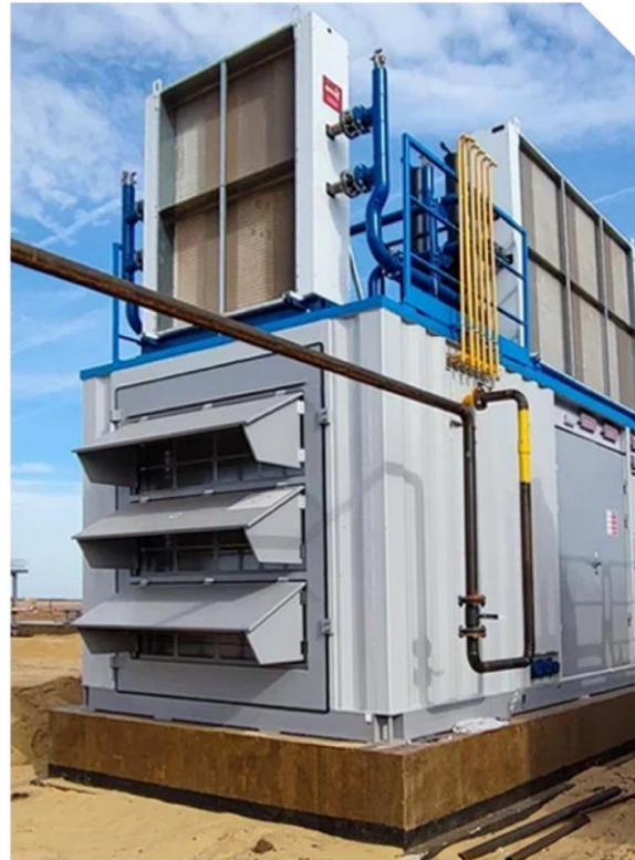
Газопоршневые установки (ГПУ)
