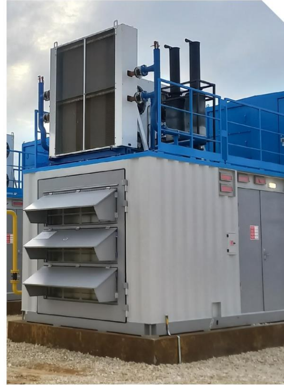
Энергокомплекс 3,5 МВт для компании «Газпром»
