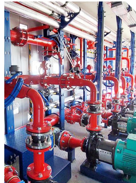
Блочные насосные станции (БНС)
