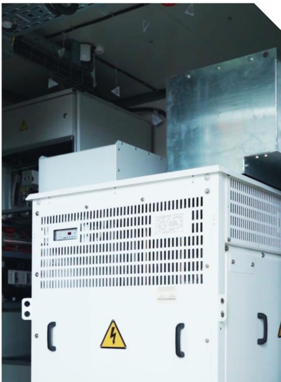
Комплектные трансформаторные подстанции (КТП)
